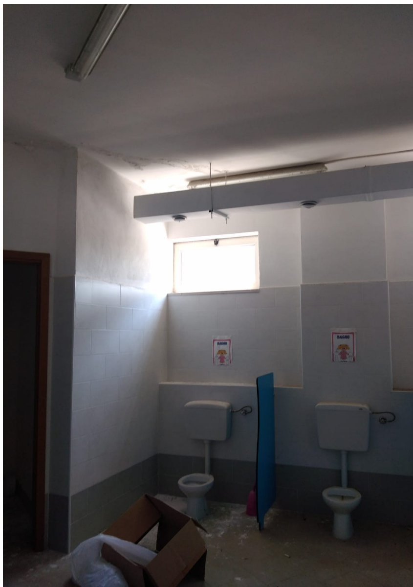
Figura 18: solaio bagno - zona wc
