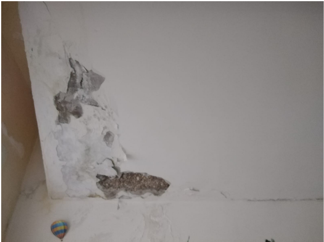
Figura 13: solaio del sottoscale - zona ingresso bagni
