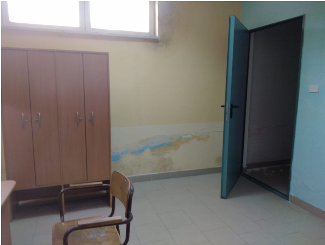
Figura 4: parete del locale spogliatoio
