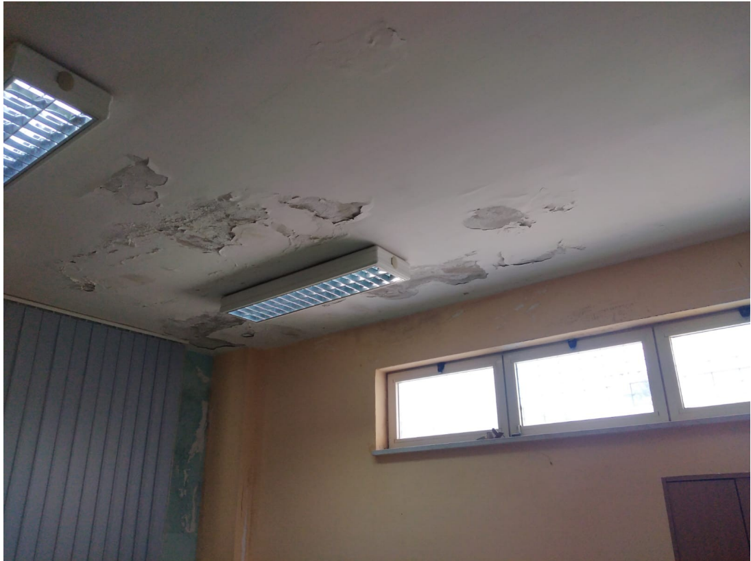
Figura 2: solaio del locale spogliatoio
