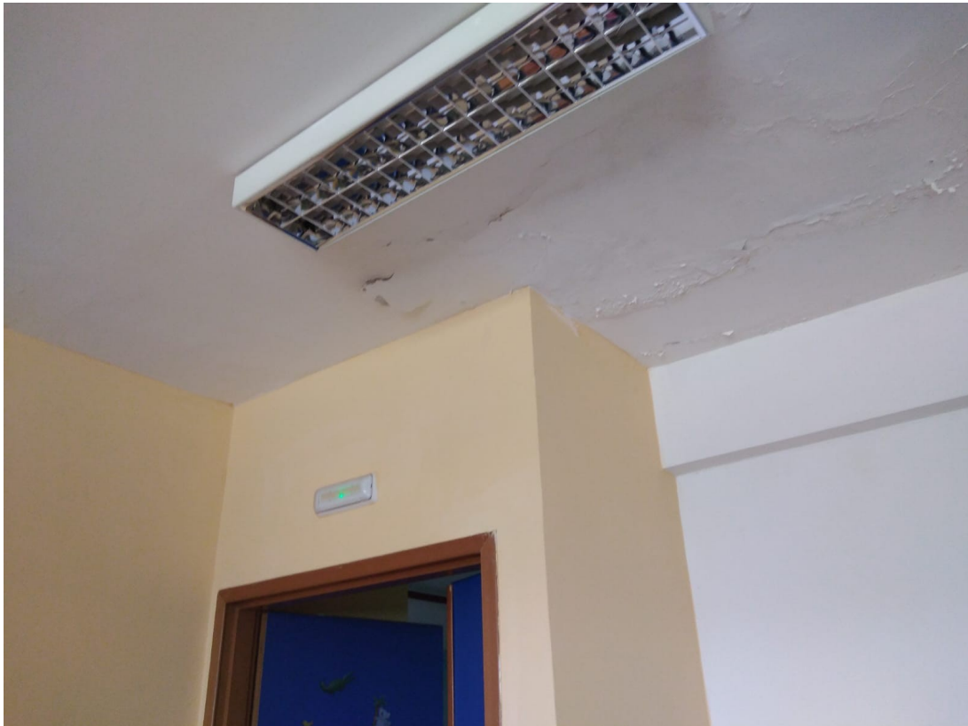
Figura 9: solaio del locale psico motorio
