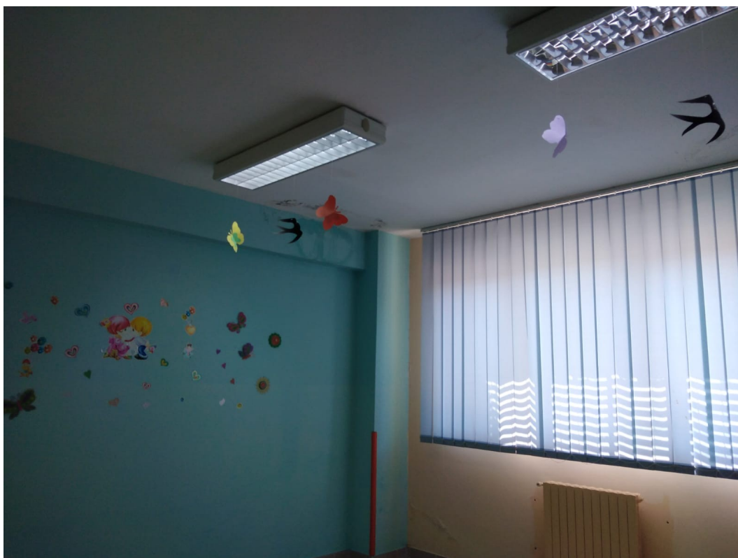
Figura 6: solaio del locale segreteria
