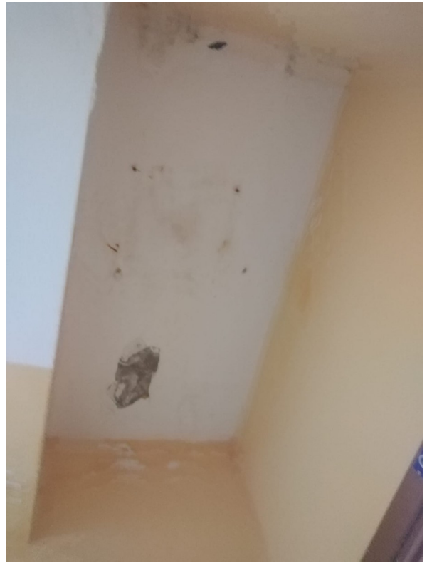
Figura 15: solaio ingresso sala attività
