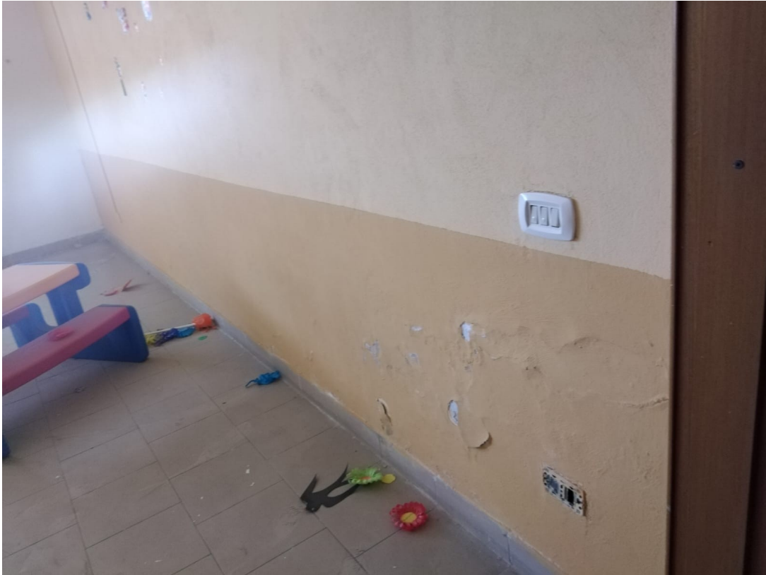
Figura 8: parete della sala attività
