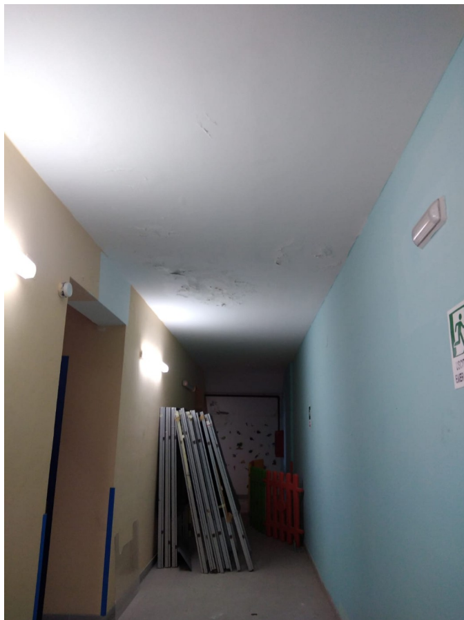
Figura 14: solaio corridoi aule e bagno
