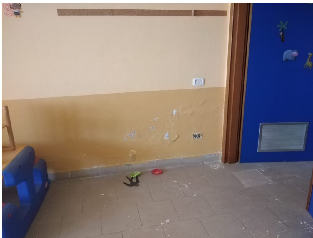
Figura 7: parete della sala attività
