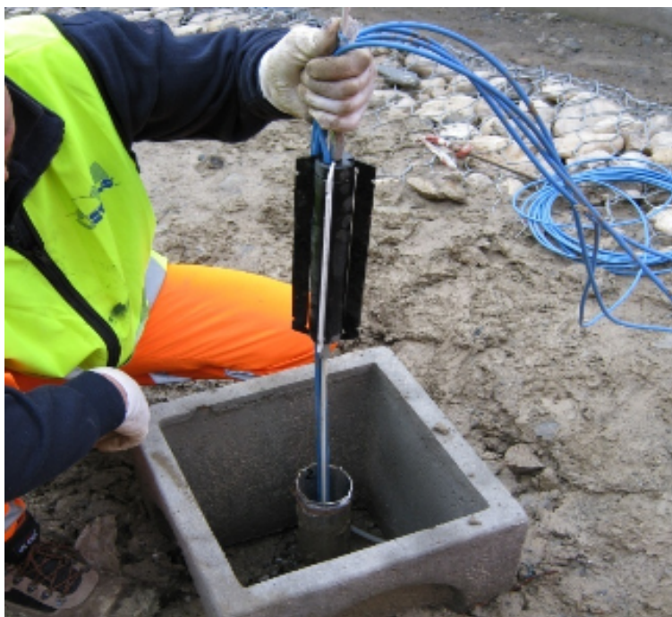
Fig. 1 – Esempio di boccaforo di tubo inclinometrico
